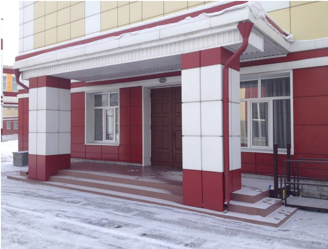
Фото №3 Основной вход
